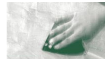
Durch das Abziehen mit der Spachtel wird die Oberfläche spiegelblank.
