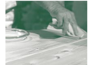
Das Pflegeöl wird mit einem weichen Lappen aufgetragen.
