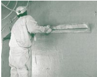
Ein spezieller Putz soll Büros aus Leichtbauwänden kühl halten.
